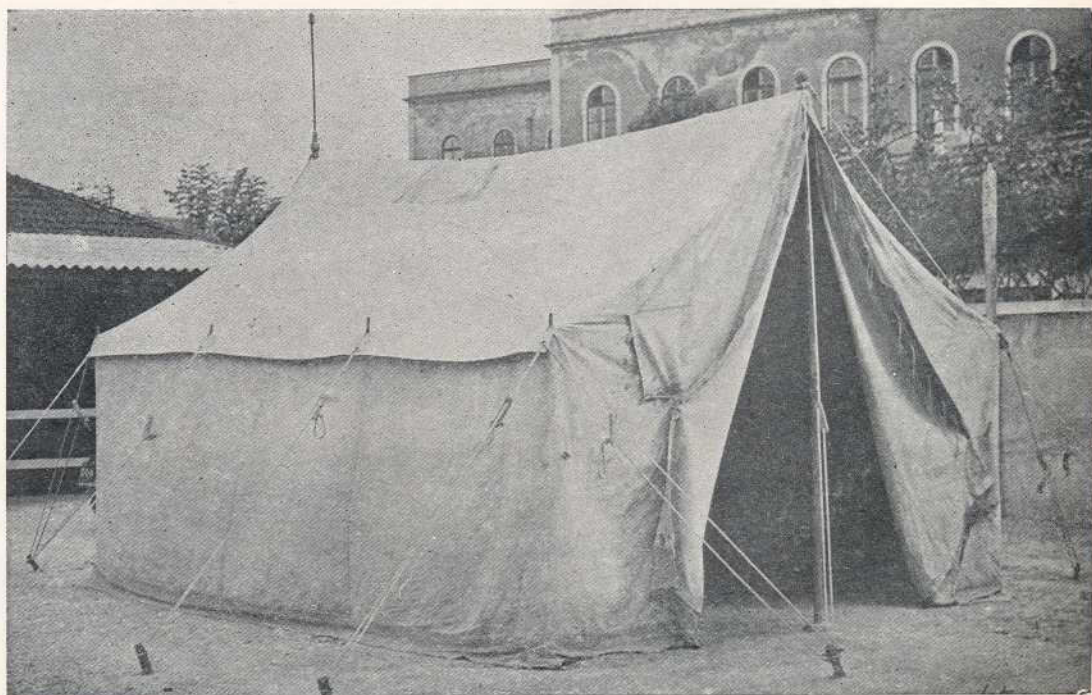
FIG. 20 — Tenda para material de desinfecção
