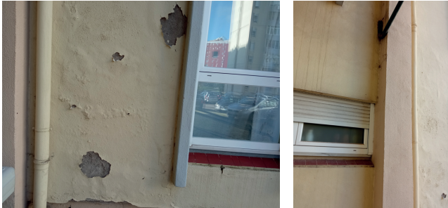
Figura 1: Exterior do edifício.
