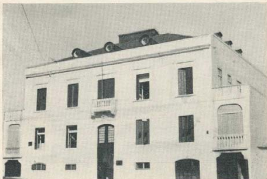
Fig. 18 — O actual Instituto Superior de Higiene Dr. Ricardo Jorge no edifício onde foi instalado em 1912, hoje insuficiente para o seu movimento
